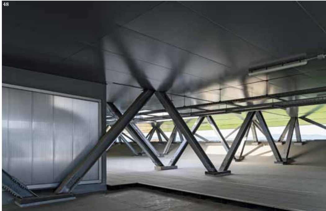
47 vista dalla grande terrazza esterna posta al piano produttivo 48 vista della copertura tecnica nello spazio interposto tra le due coperture e delle travi reticolari che collegano i bipodi lato est ai tripodi di lato ovest 49 vista verso ovest dallo spazio di lavoro sul paesaggio esterno
